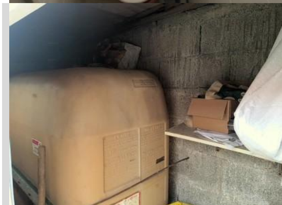
Extérieur Abri cuve
